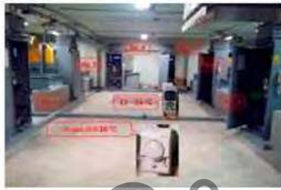
รูปที่ 3 ค่าอุณหภูมิโดยรวมที่โรงห้องเครื่องไฟฟ้า เมื่อมีการเติมอากาศด้วยพัดลมควบคุมที่การทำงานของเครื่องปรับอากาศระบบเดิม โดยตั้งเทอร์โมสแตทไว้ที่ 20 °C
